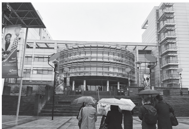
(写真26) GCU 外観
